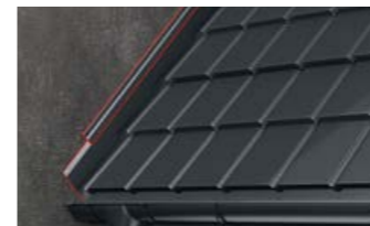
Oplechování ke zdi s dilatační lištou
